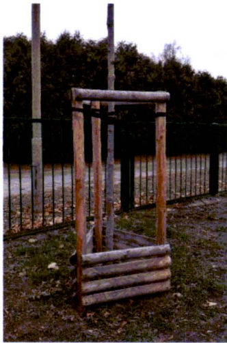
Ryc. 28. Solidne zabezpieczenie drzewa przy ciągu jezdnym.
