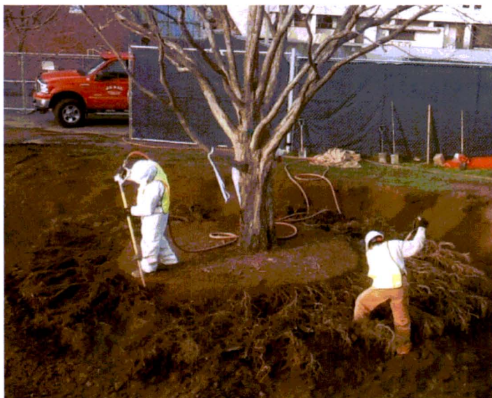
Ryc. 10. Odsłanianie systemu korzeniowego za pomocą sprężonego powietrza – przygotowanie drzewa do przemieszczenia (źródło: https://takingplaceinthetrees.net/category/air-spade/ ).
