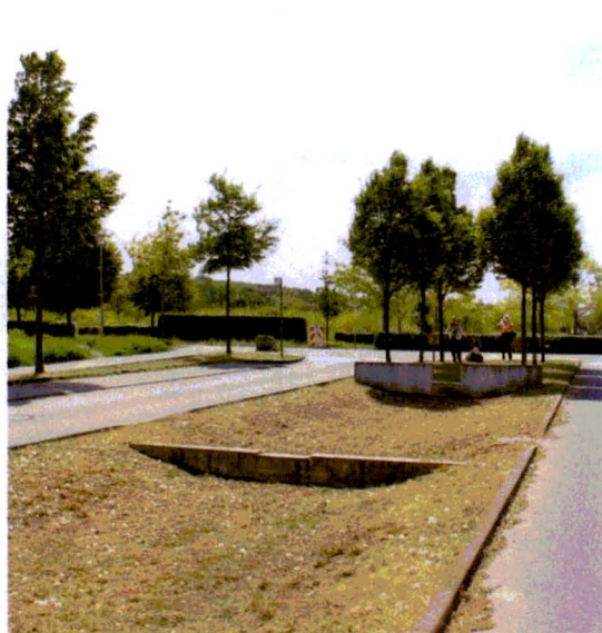
Ryc. 18. Retencja wód w pasie drogowym - muldy chłonne z systemem spiętrzeń umożliwiającym zatrzymanie i wsiąkanie wód. Fot. Ł. Dworniczak
