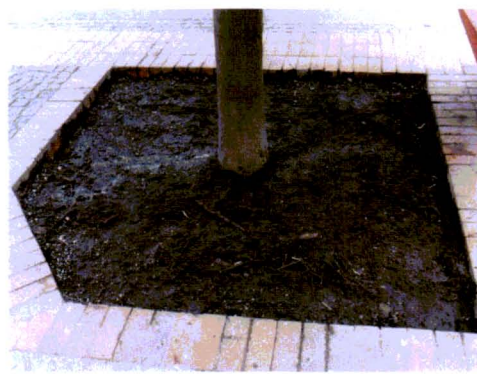
Ryc. 40. System korzeniowy po uzupełnieniu
