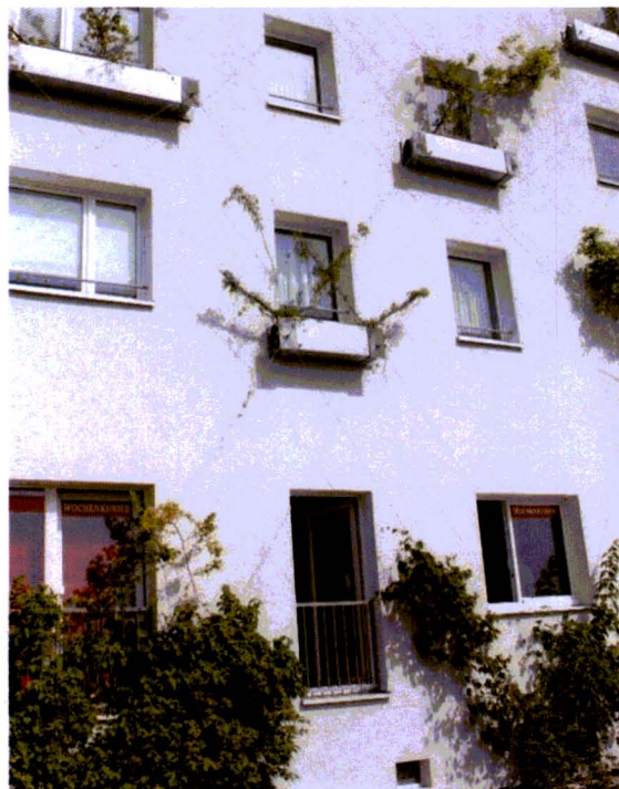
Ryc. 35. Konstrukcje dla pnączy na elewacjach. Fot. Ł. Dworniczak.
