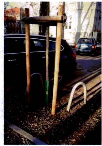
Ryc. 30. Zabezpieczenie drzewa za pomocą osłonki na pniu oraz ograniczników wjazdu.
