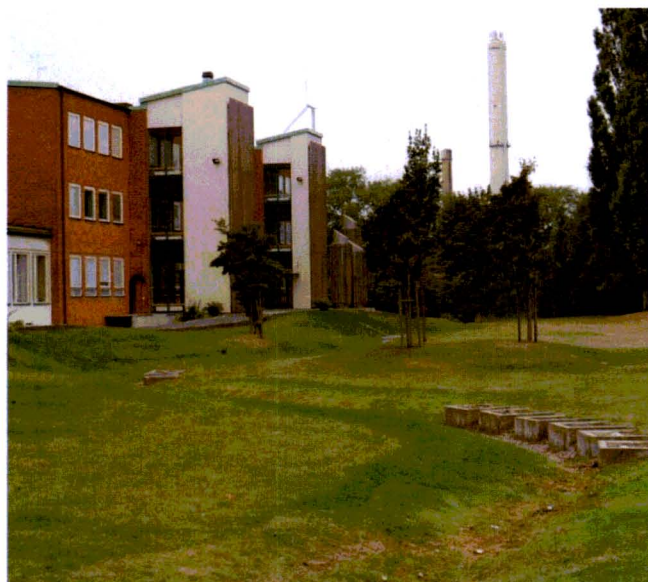
Ryc. 17. Ukształtowanie terenu i mulda chłonna umożliwiające retencję wody na terenie zieleni. Fot. Ł. Dworniczak
